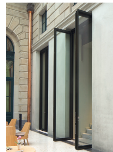
Überhohe Eingangstüre isoliert
