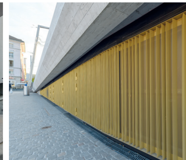
Verdeckt liegende Türen mit Lochblechtrapez-Verkleidung
