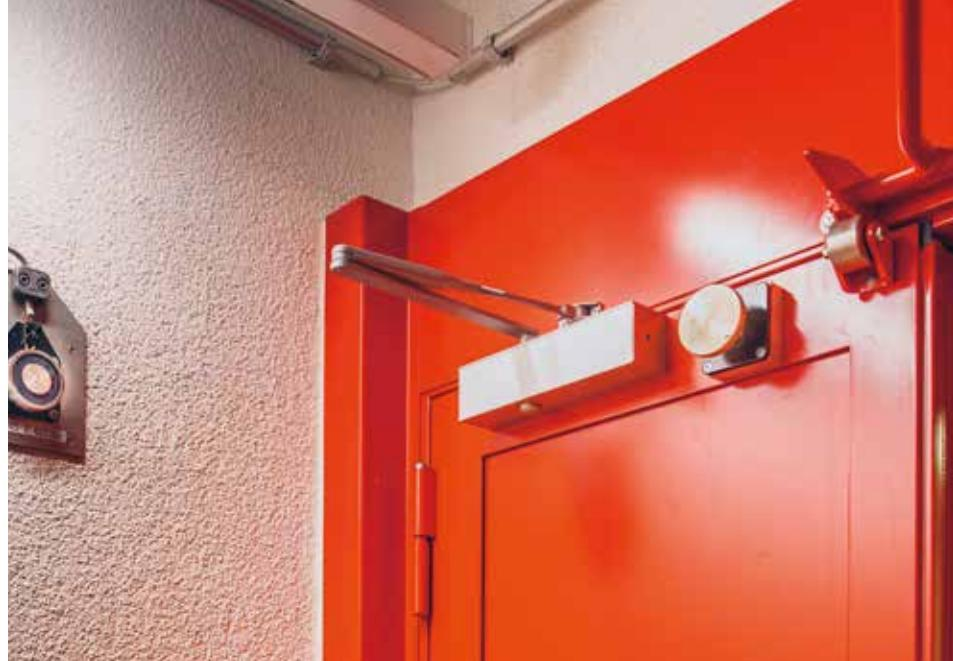
**Vor Inbetriebnahme erfolgten anspruchsvollste Prüfungen, welche die Funktionstüchtigkeit, aber auch das Zusammenspiel von Magnet-Offenhaltesystemen mit Schliessfolgeregelung und den Verschlusskomponenten testeten.**
